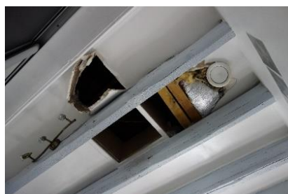
Trappe d'accès aux combles
